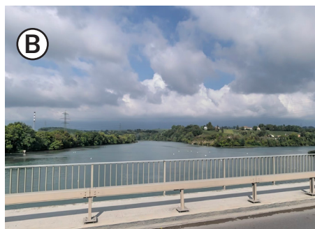
Barrage du Rhône
